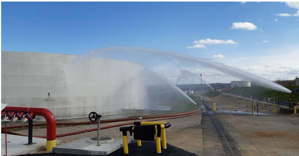
**3 canons Akron avec têtes TurboMaster Akron régler à 240M3/h et 300M3/h**
